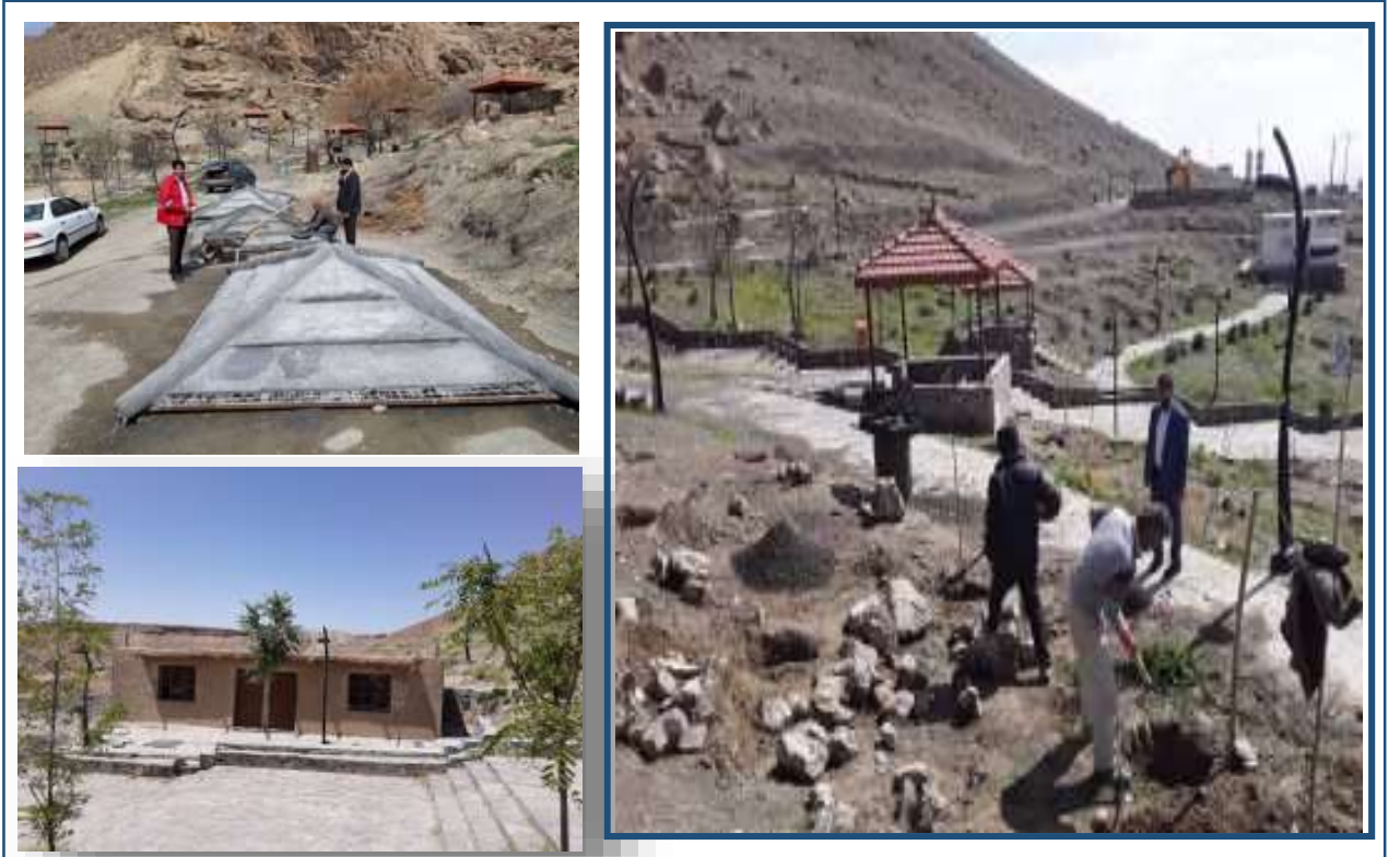
عملیات توسعه فضای سبز و تکمیل فضای سبک اقامتی در قالب ۶ آلاچیق به همراه ایمن سازی دهانه ی اصلی غار در پارک گردشگری تفریحی غار مزدآوند
