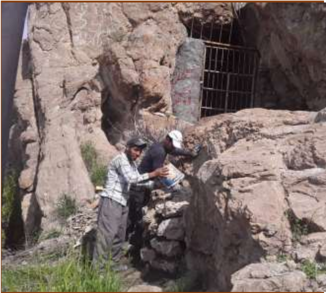
پروژه ایمن سازی ورودی دهانه ی اصلی غار مزدآوند
