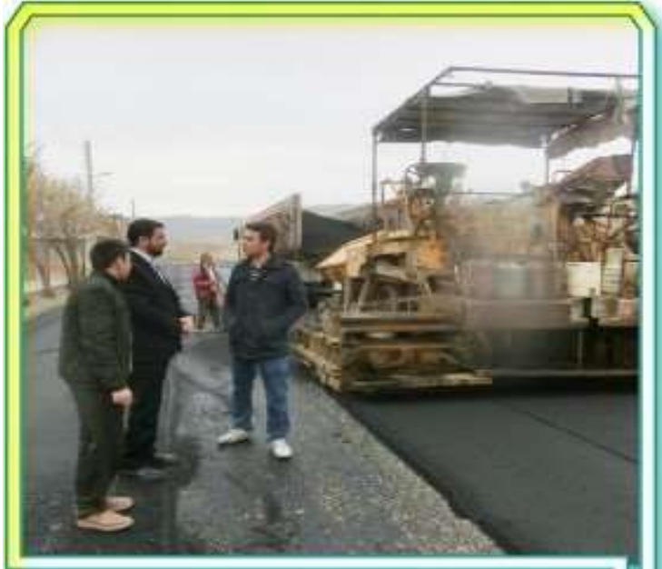
پروژه ترمیم آسفالت معابر شهری
