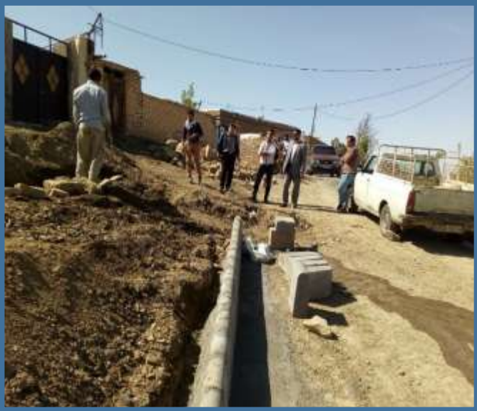
پروژه زیرسازی، آماده سازی و آسفالت نهایی کوی مولوی
